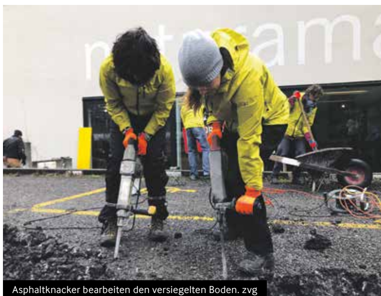
Asphaltknacker bearbeiten den versiegelten Boden. zvg
